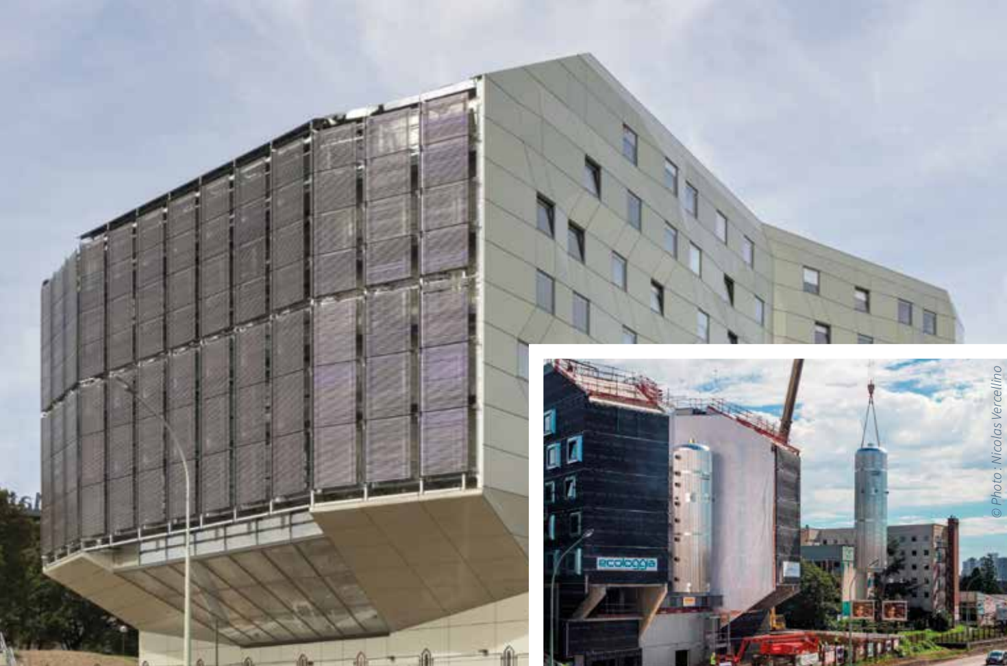
ANMA/ © Nicolas Vercellino | Maison de l'Île-de-France (2017) – Architecte : Olivier Calvaresi Projet Zéro-énergie comprenant 2 cuves de stockage de 80 m 3 chacune.
