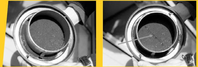
FIGURE 4 Exemple d'encrassement d'une bouche d'extraction (1). La flèche indique une zone désencrassée au passage d'un doigt.
